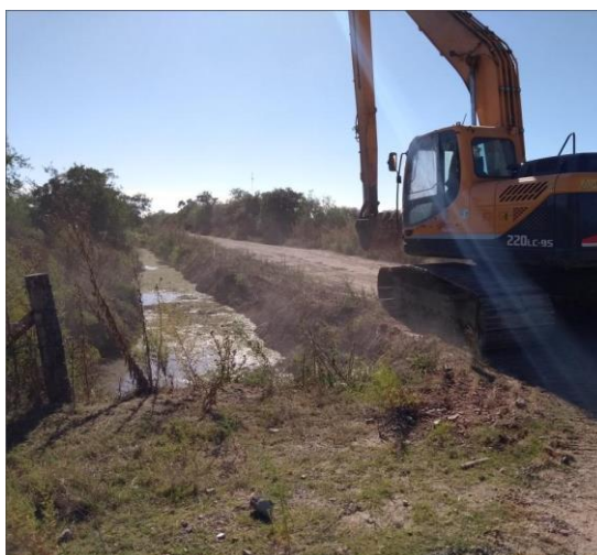
Figura 5.1. Canal modificado y ampliado con retroexcavadora.
