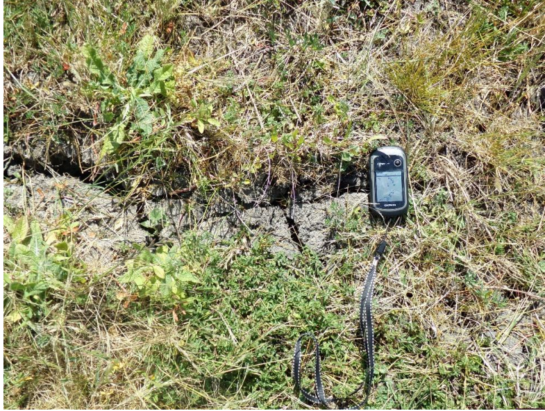
Figura 4.2.1. Importantes grietas superficiales.
