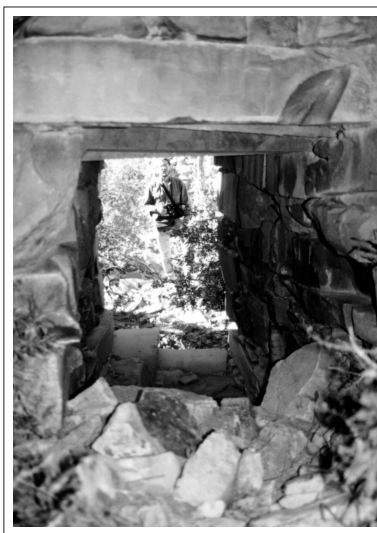
▲ Figs. 2 a 5: Imágenes del puente de Ñoquera.
