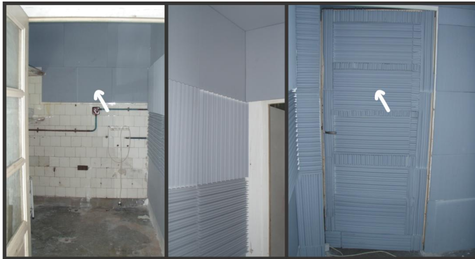
Figura 11. Adecuación de un cuarto mediante paneles fonoabsorbentes (se indican algunos paneles con flechas) para la grabación de sonidos con bajos niveles de ruido de fondo, asemejando las condiciones a las de una cámara anecoica
