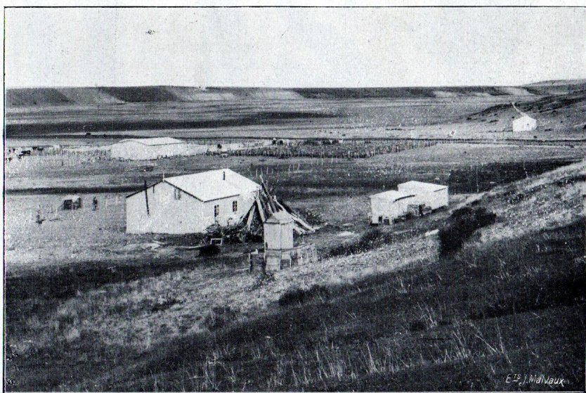
Fig. 2. — Un établissement d'élevage (« estancia ») dans le sud de la Patagonie. Large vallon (« cañadon ») montrant une « vega » en son milieu; dans le fond, le plateau parfaitement horizontal. — Communiqué par M. Morrisson.
