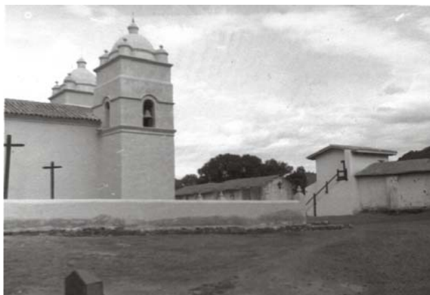
FOTO 9.- Vista lateral de la Iglesia San Pedro Nolasco. Frente a ella, la nueva Hostería, reconstrucción de la antigua Hacienda de Molinos. MM/M.3.7. Foto 6. Febrero 1982.
