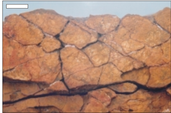
Fig. 4-9. Grietas de desecación. Barra 2 cm.
