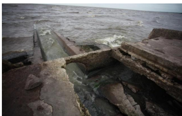
Figura 3.3 Descarga cloacal de la planta sobre la costa (Fuente: Diario El Día de La Plata, 2018)
