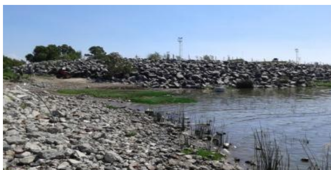
Figura 3.1.1.3.d. Bajada a la playa rodeada de escombros y relleno del terreno
