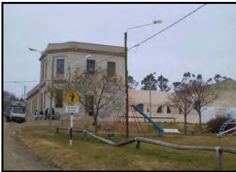
Figura 99. Escuelas Primaria N° 4 y Secundaria N° 15.
