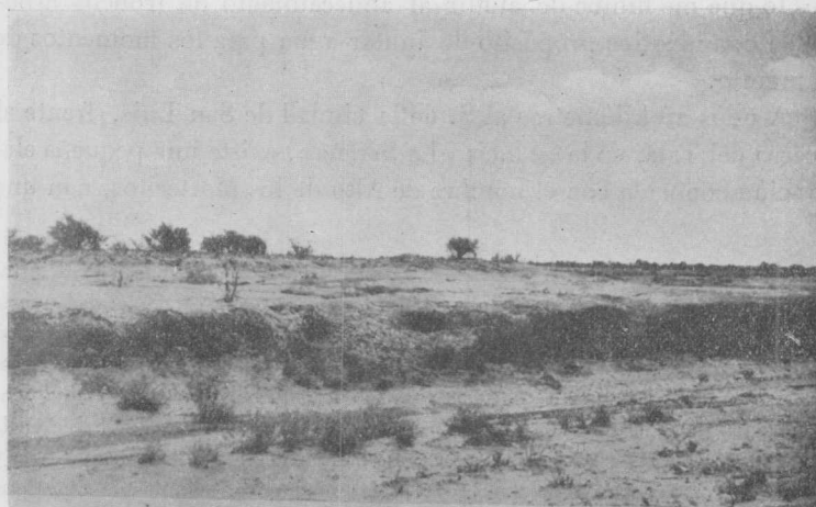
Fig. 20. — Vista general de la Represa del Carmen
