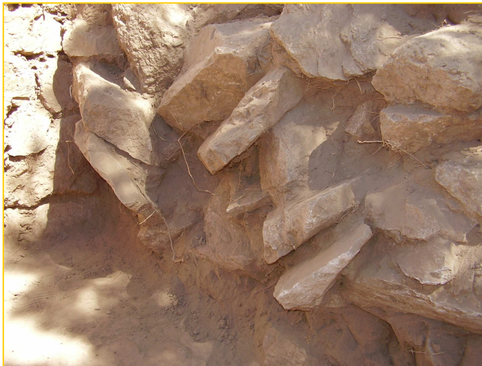
Imagen V.20 y V.21 La imagen superior muestra una vista general de la cara sur del Tabique B de la KU. La imagen de la izquierda es un detalle de la base de dicho tabique en el que se observa, en la base del mismo, un principio de pérdida de solidez y cohesión.
