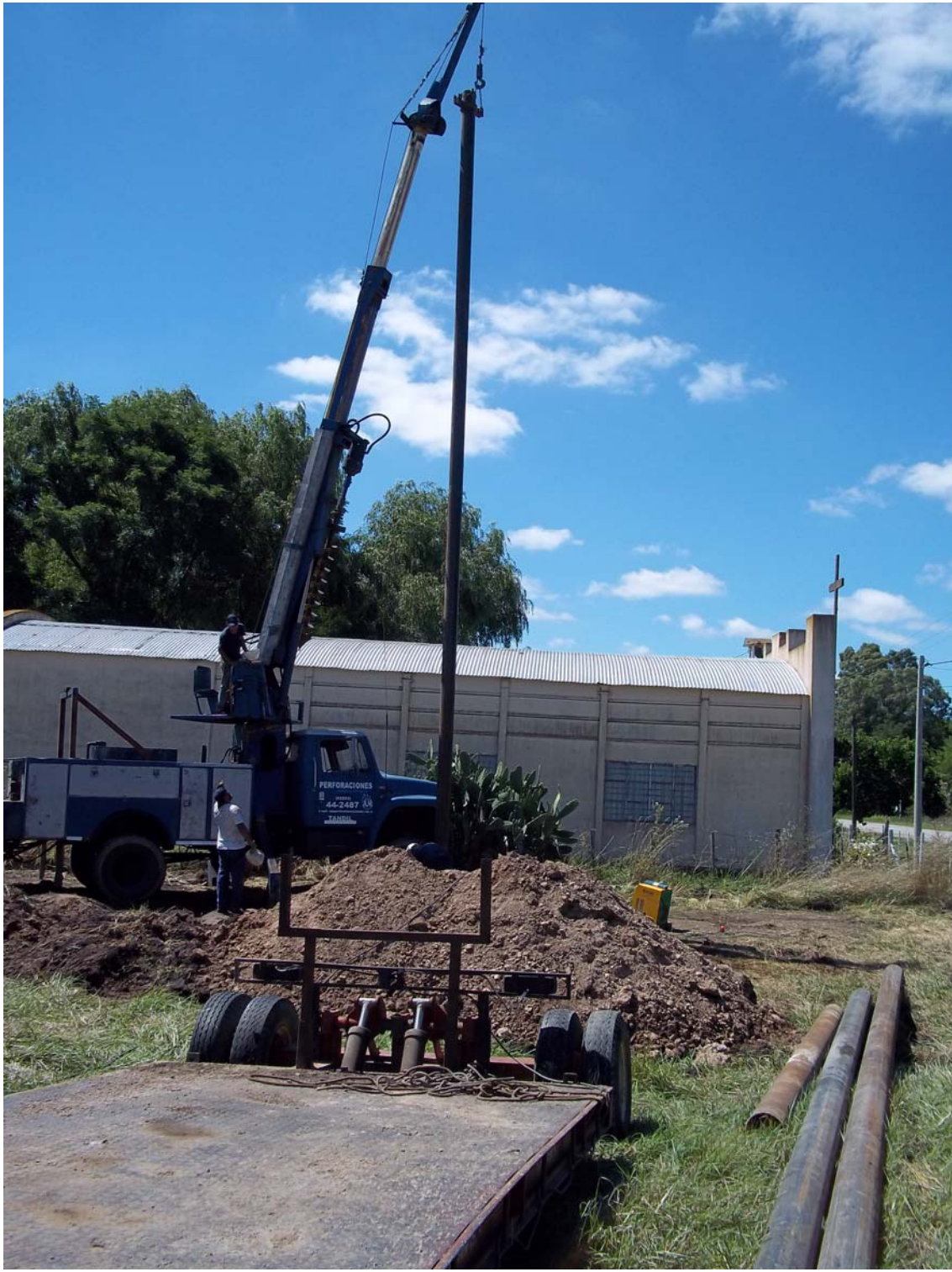
Pozo de Producción DLC1 – Vista del izado de la cañería de acero de diámetro 8” instalada como prolongación de los filtros de acero inoxidable.
