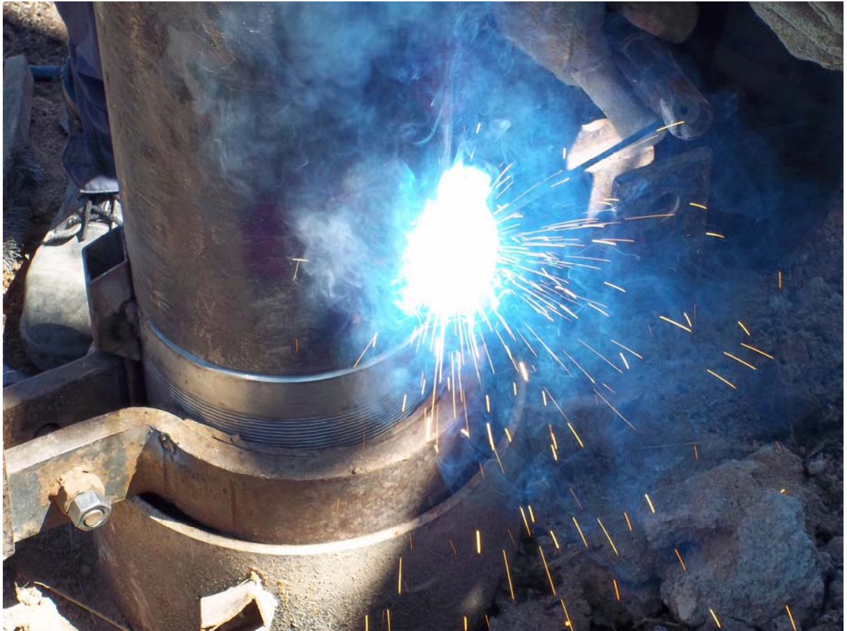
Pozo de Producción DLC1 – Soldadura del anillo de acero inoxidable entre los filtros del mismo material y la cañería de prolongación de filtro, ambos de 8" de diámetro.
