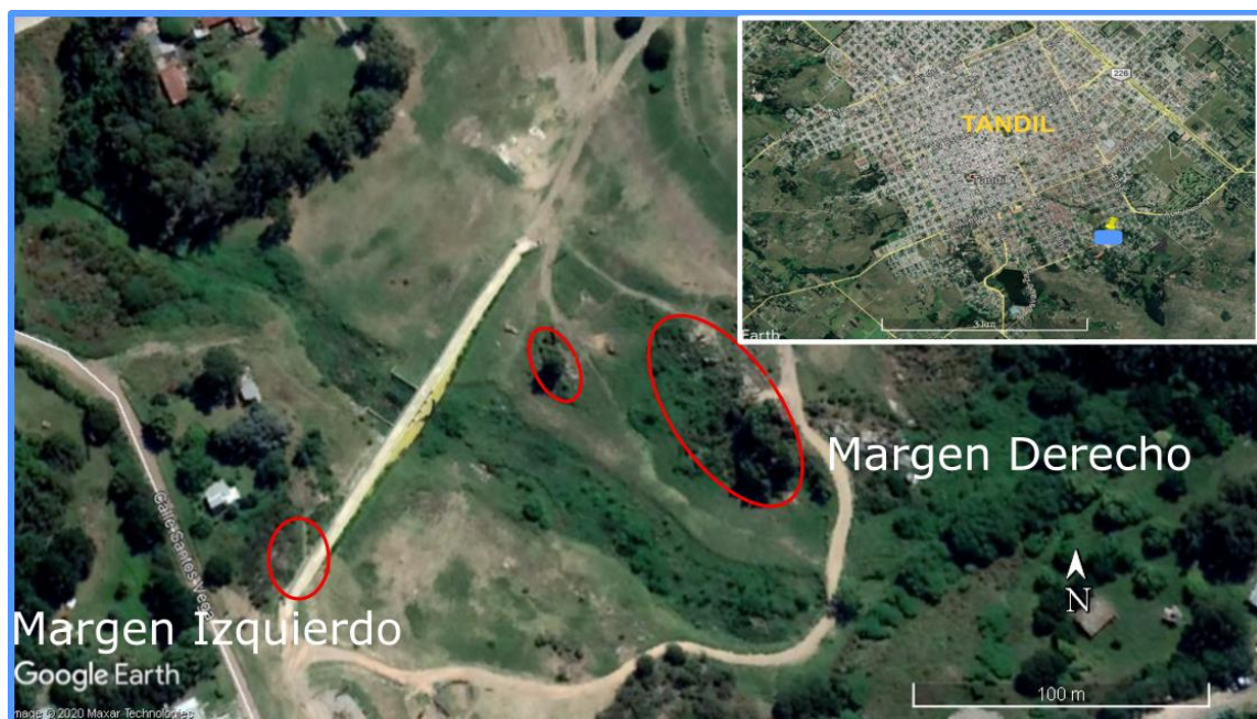
Figura 12.- ubicación de la presa Ramal H. en rojo se señalan los afloramientos de macizo rocoso aflorantes en cada margen.
