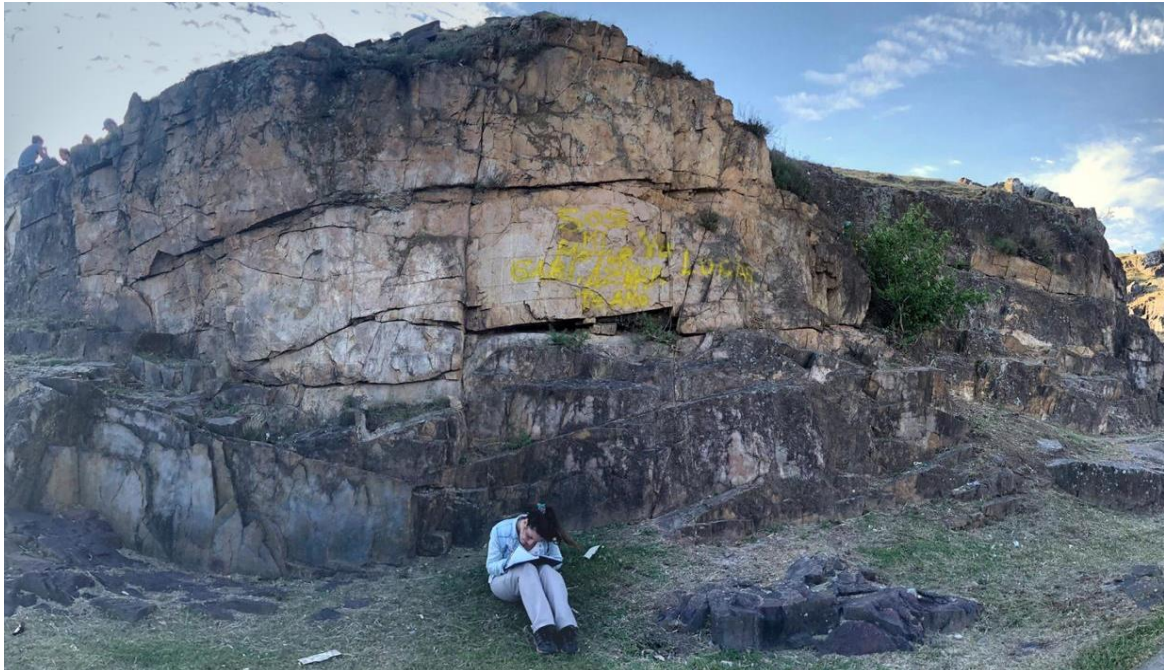
Figura 24.- Afloramiento en el margen izquierdo de la presa del Fuerte, donde se observa un macizo altamente meteorizado en su base en contacto con un macizo con escasa a nula alteración.
