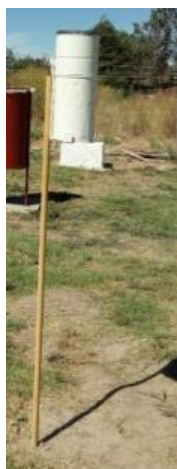
Foto 3. Instalación de pluviómetro tipo B del SMN en la localidad de Arata.
