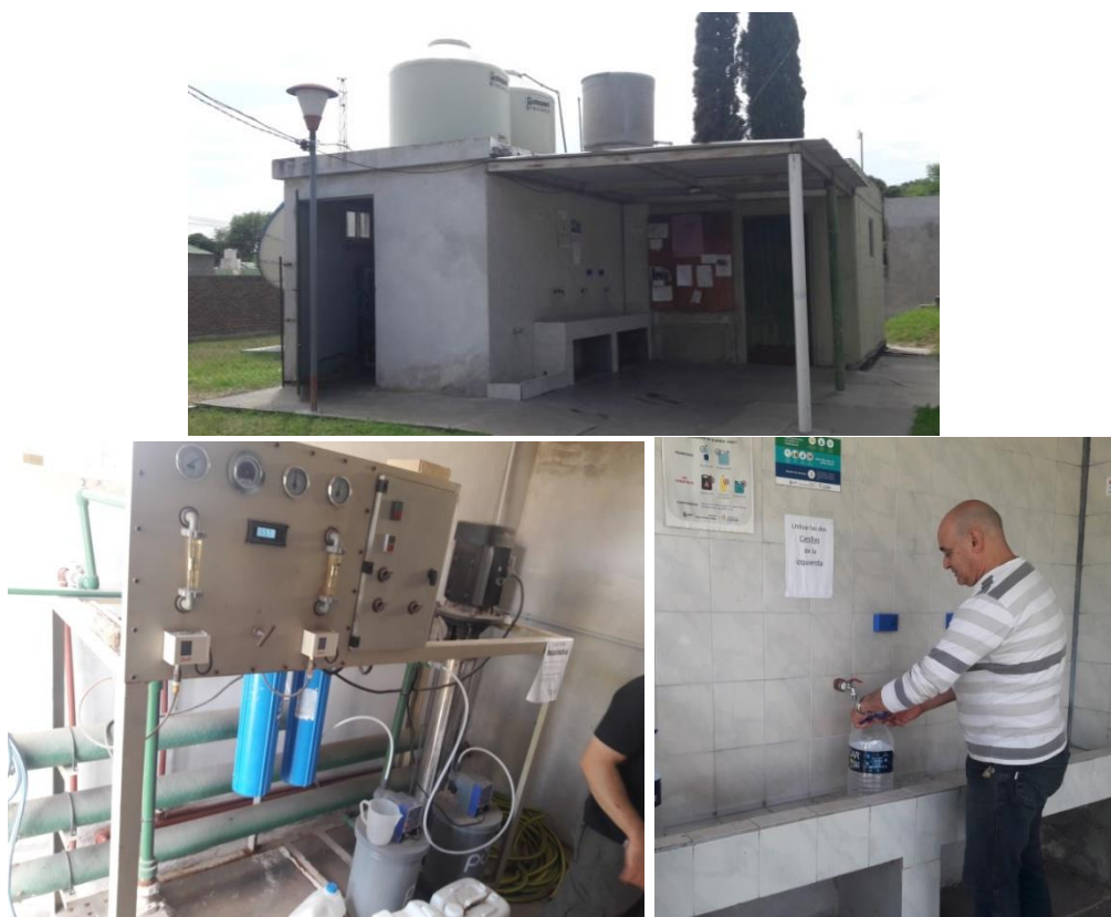
Foto 23. Planta de ósmosis inversa y servicio de agua potable para la comunidad brindado por la COSEPAR (Cooperativa de Servicios Públicos de Arata), en la localidad de Arata.
