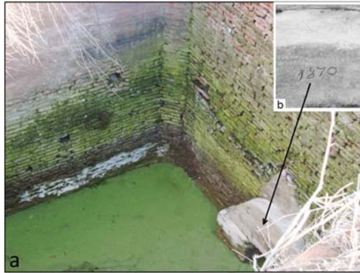
Figura 6. a, Reservorio de agua; b, Detalle de la boca del túnel.
