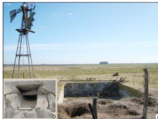
Figura 9, a Pileta de almacenamiento de agua; b, Boca del túnel que descarga el agua conducida desde la piletita
